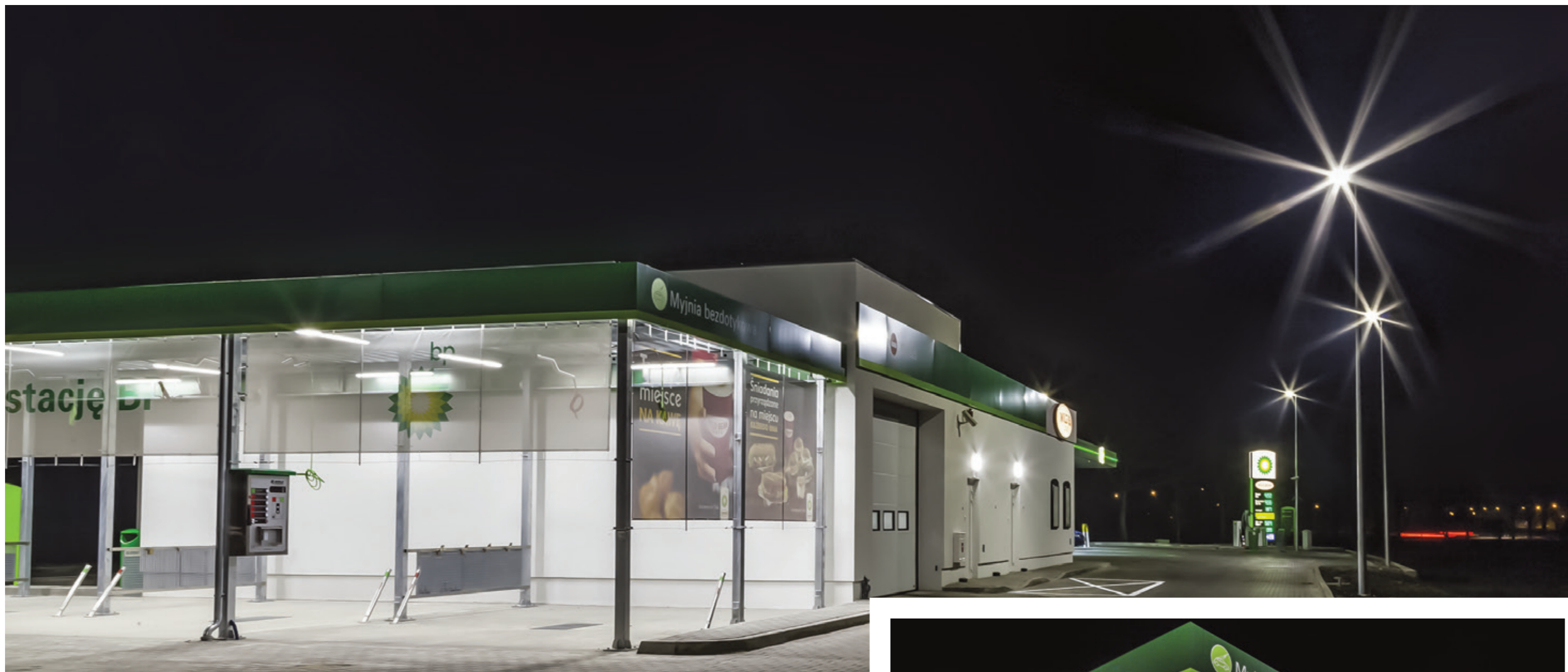
Oświetlenie Stacji paliw w Bochni.
